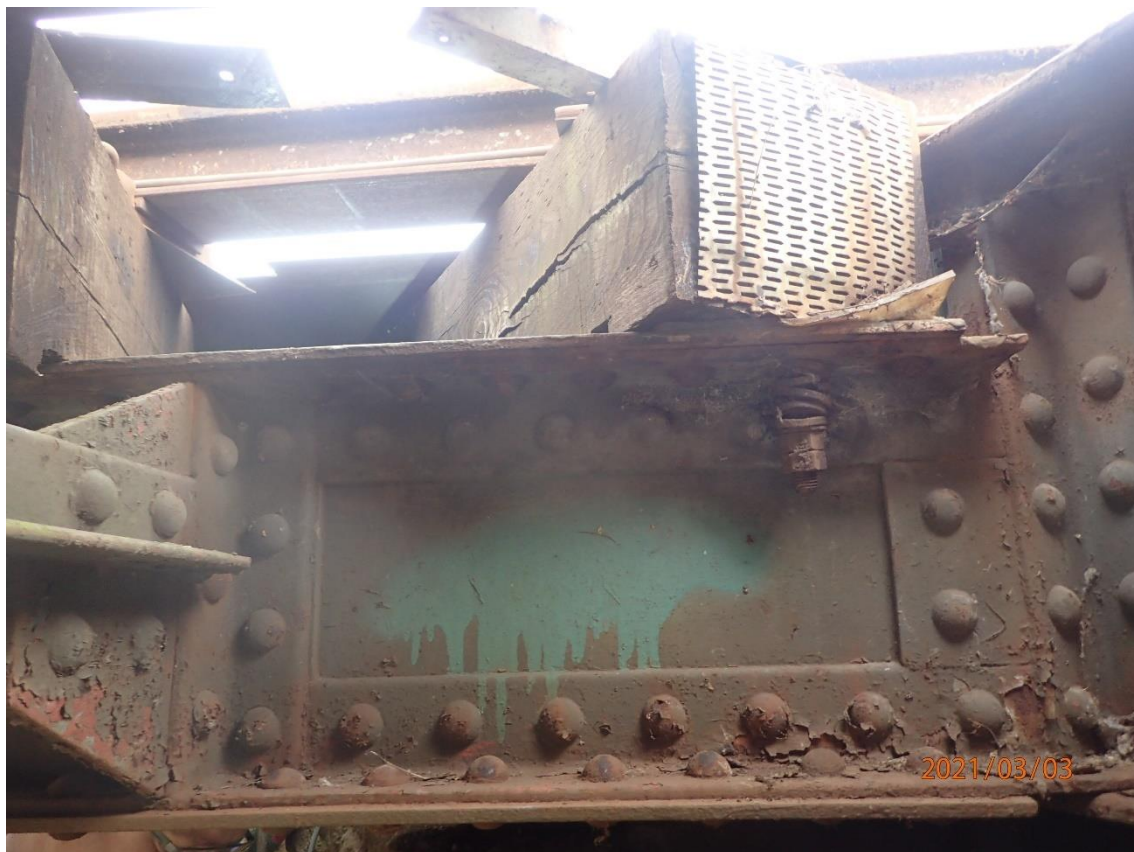
Obr. 27: Koncová oblast OP1 po demontáži chodníkových plechů
