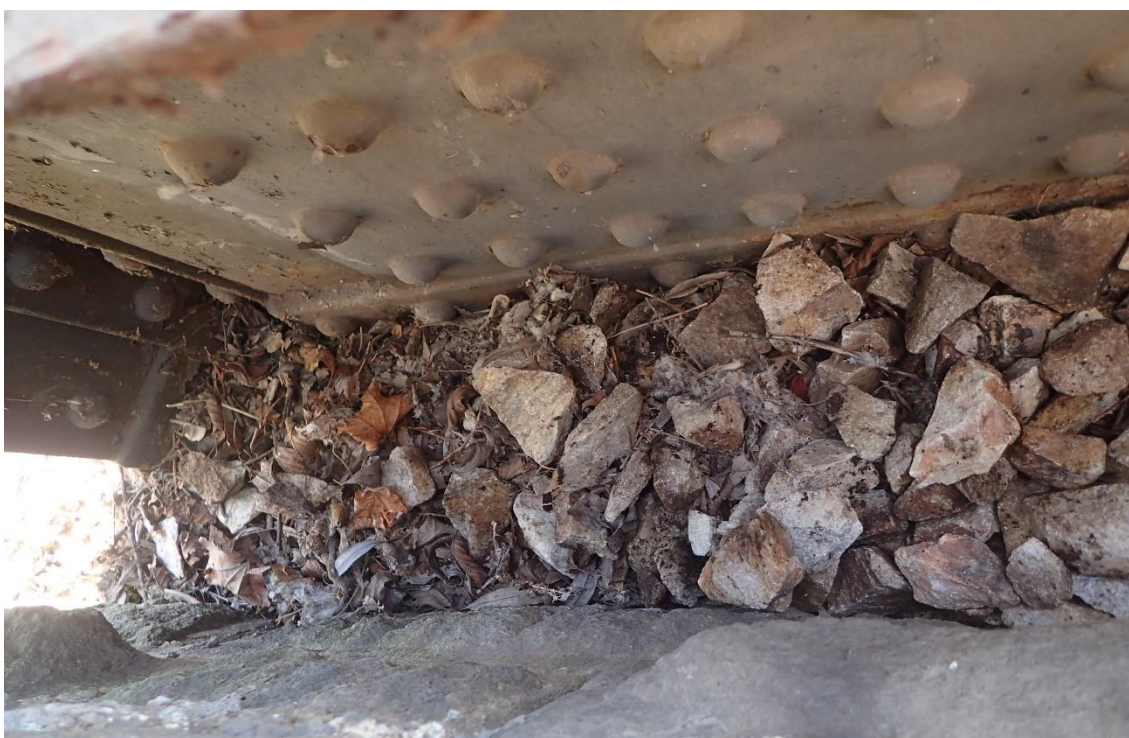
Obr. 44: Propad štěrkového lože na OP2
