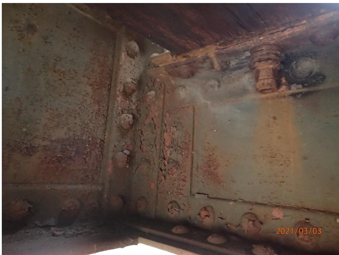
Obr. 17: Poškození PKO a koroze příčnicku a podélníku
