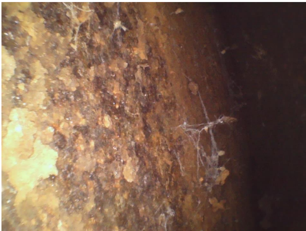
Obr. 31: Korozní oslabení spodní pásnice koncového příčnicku OP1 (endoskopie)
