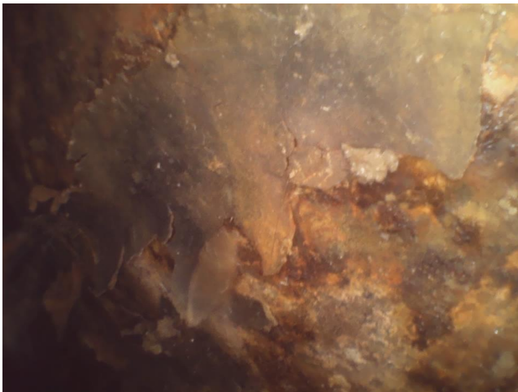
Obr. 30: Korozní oslabení spodní pásnice koncového příčnicku OP1 (endoskopie)
