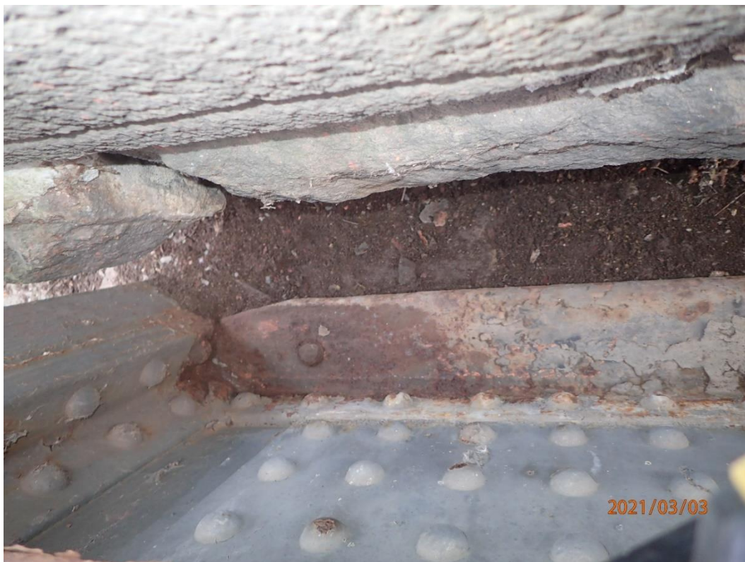
Obr. 29: Koroze spodní pásnice koncového příčnicku OP1 (shora)
