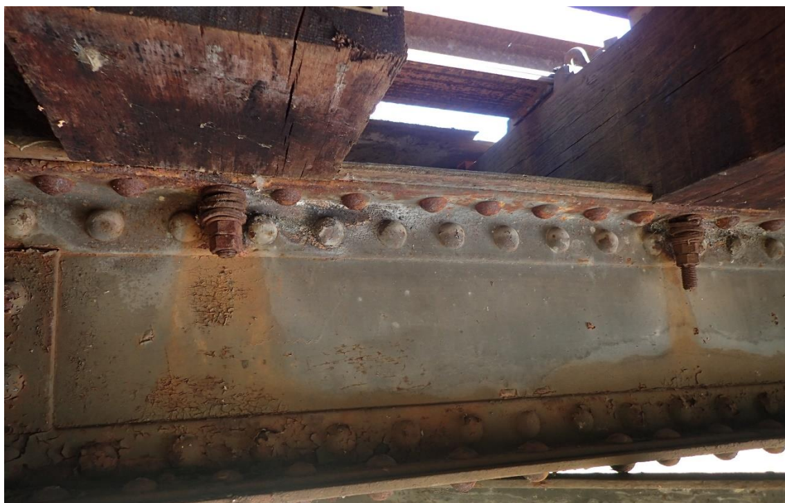
Obr. 34: Lokální koroze podélníků pod mostnicemi
