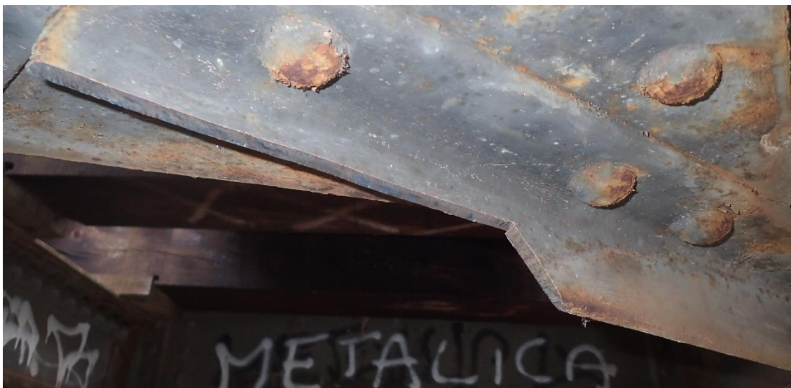
Obr. 57: Místo po odběru vzorku ZT-U před začištěním
