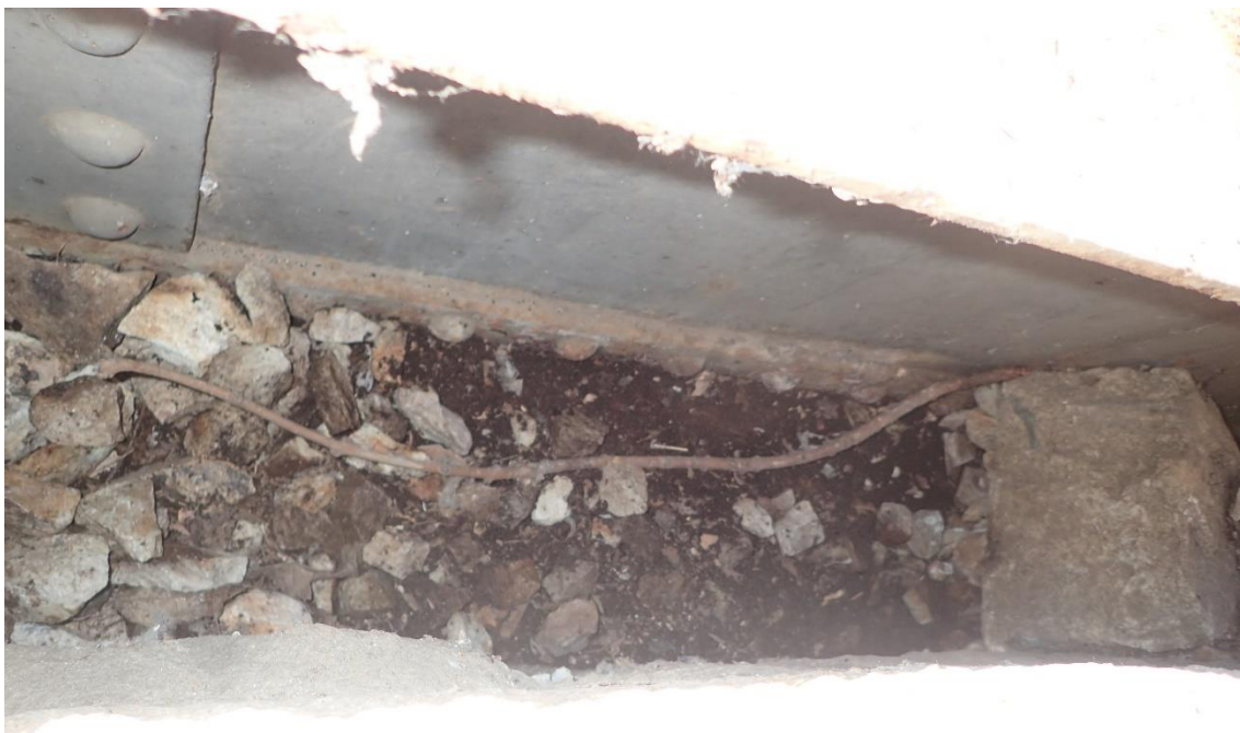
Obr. 49: Uvolněný kamenný blok OP2
