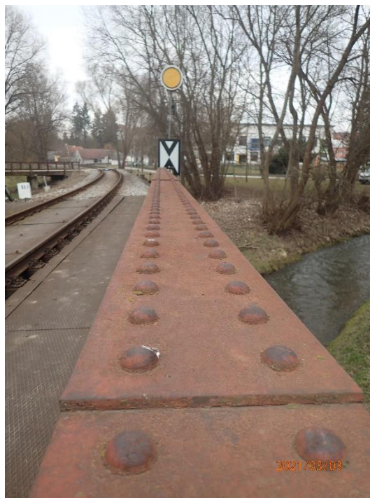
Obr. 14: Poškozená vrstva PKO a koroze – horní pásnice a koncová výztuha
