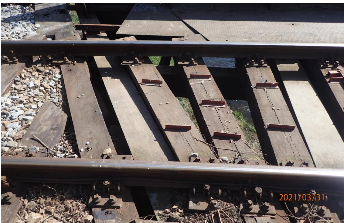
Obr. 50: Demontáž pochozích plechů a očištění OP2
