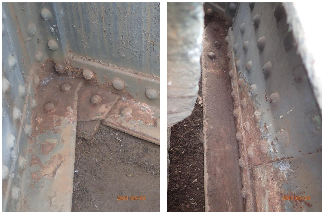
Obr. 28: Koncový příčník OP1 po očištění (vlevo u ložiska, vpravo u závěrné zídky)
