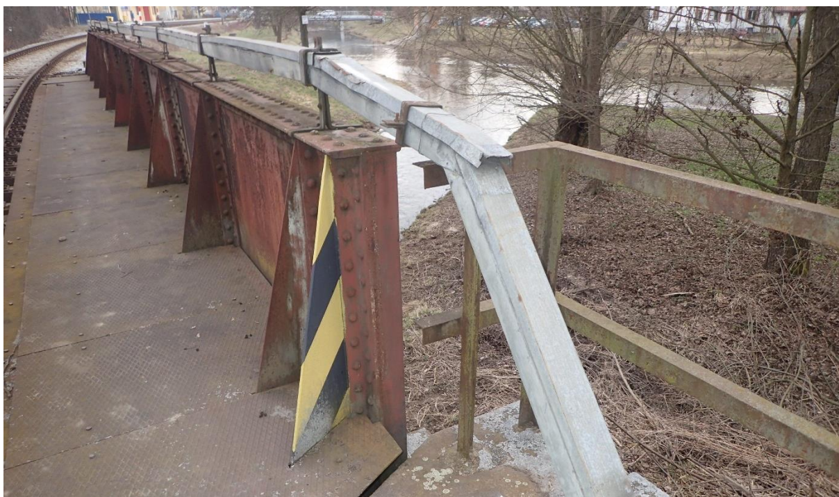
Obr. 20: Kabelové vedení na horní pásnici levého nosníku
