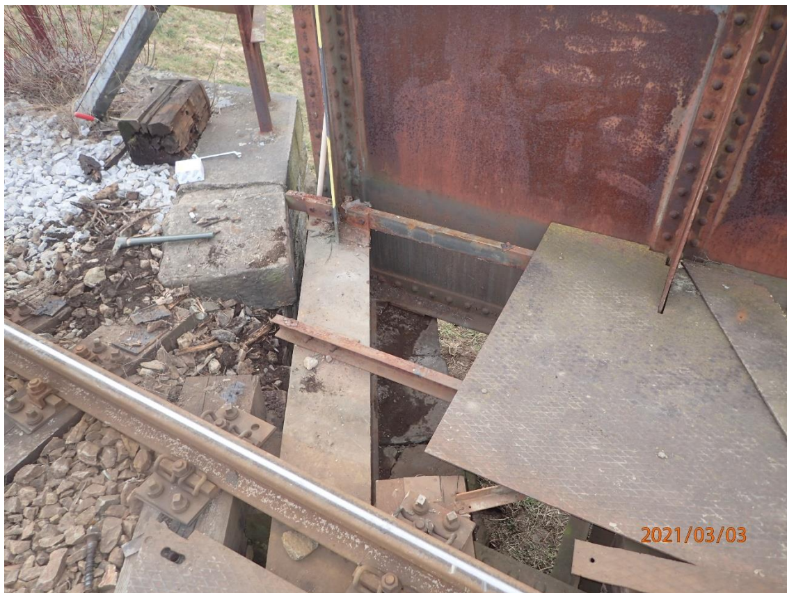
Obr. 47: Očištěný úložný práh a závěrná zídka na OP1
