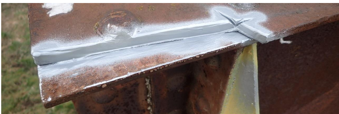
Obr. 58: Místo po odběru vzorku LN-P po začištění a ochranném nástřiku
