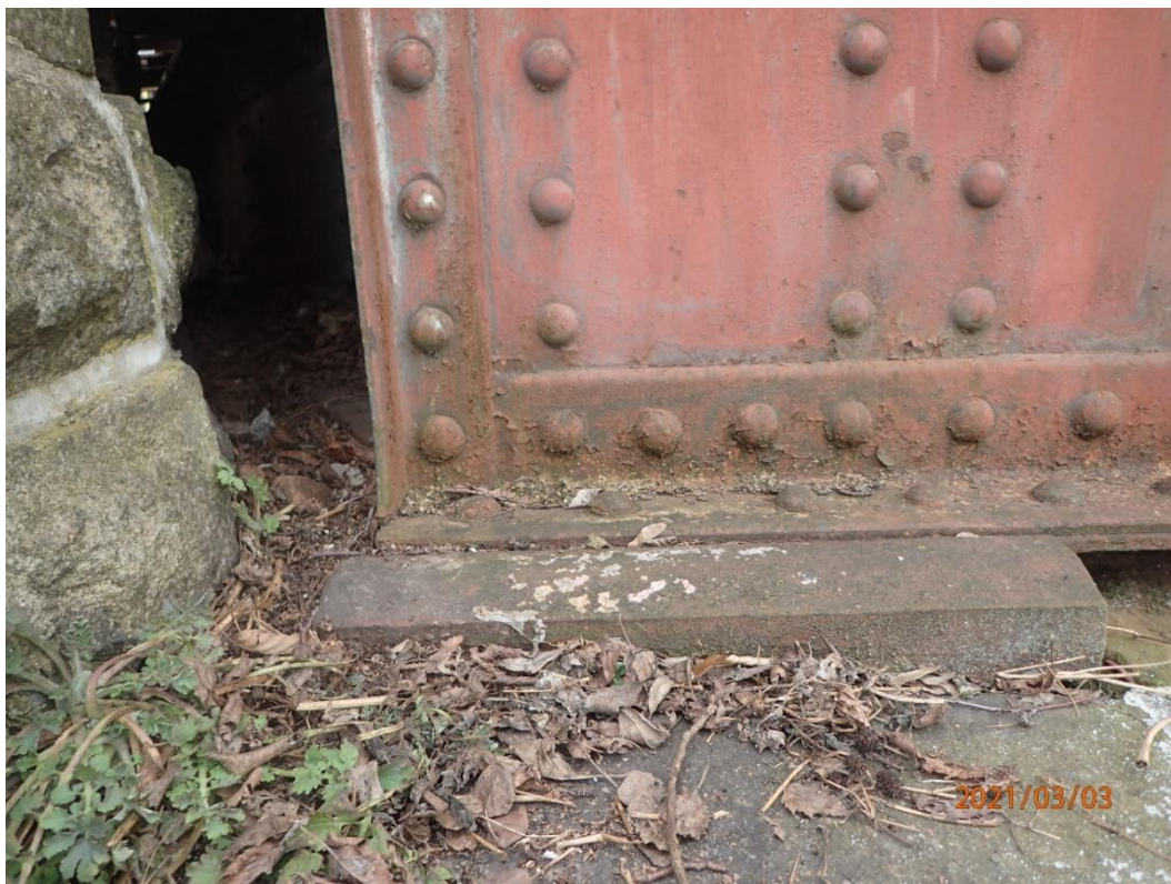
Obr. 37: Tangenciální ložiska u OP2 – původní stav
