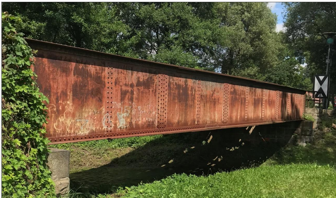
Obr. 1 Pohled na mostní konstrukci. OK prakticky bez PKO.
