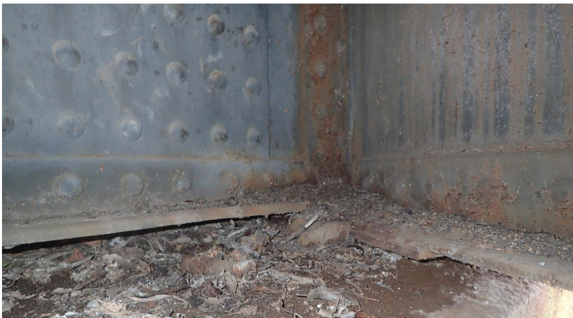
Obr. 23: Nečistotami zanesený koncový příčník
