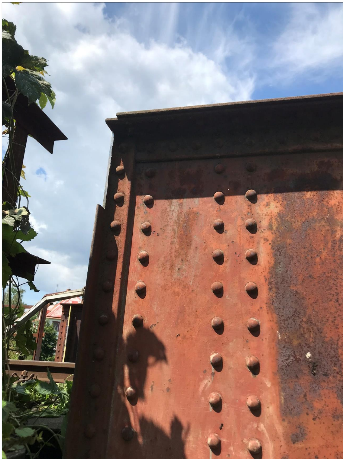
Obr. 3 Vzorek číslo 2-2 – L výztuha nad opěrou
