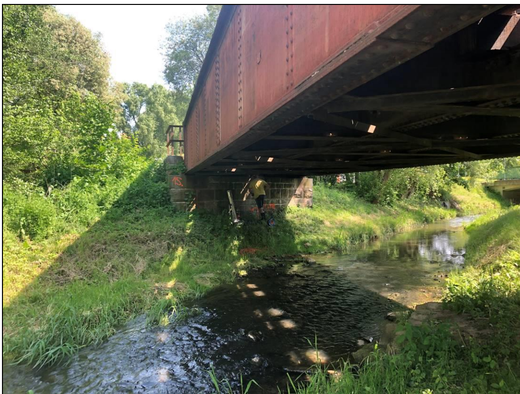
Obr. č. 8 – pohled na nosnou konstrukci a opěru Telč
