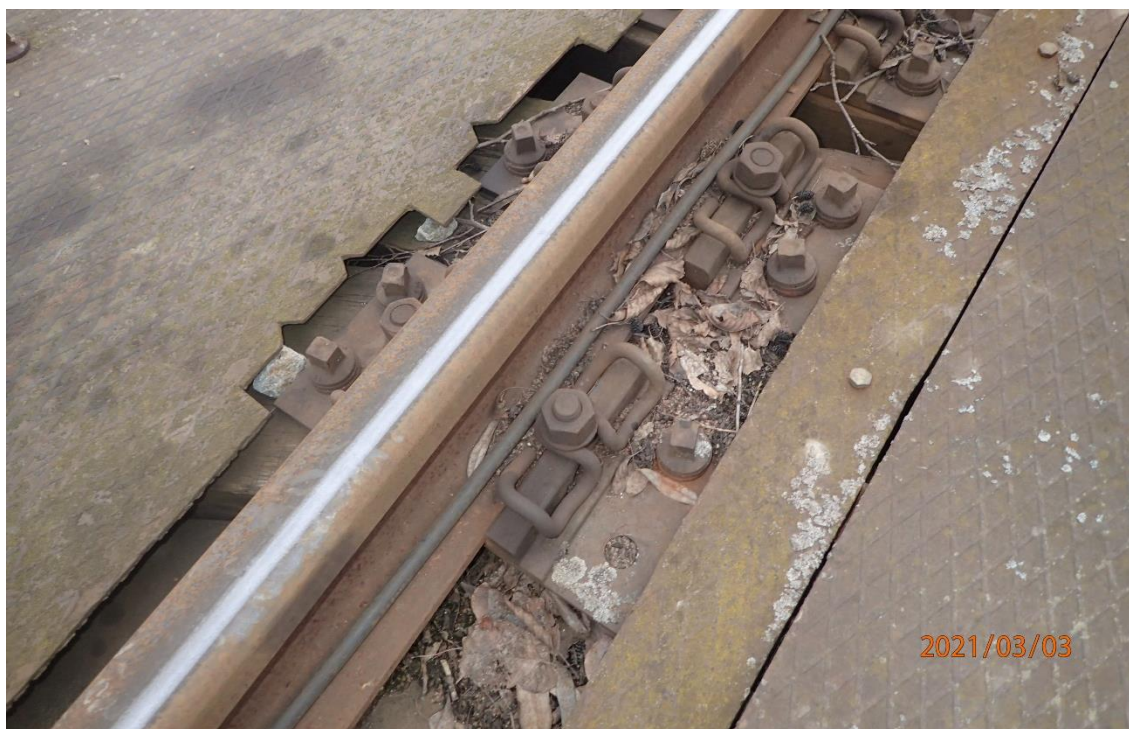
Obr. 39: Volně položený kabel u paty kolejnice
