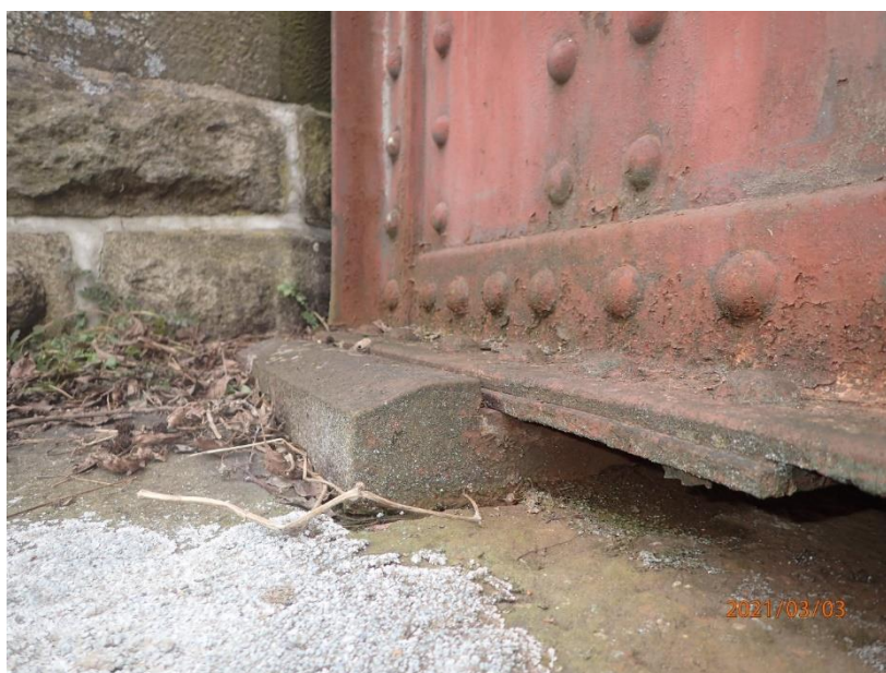
Obr. 36: Tangenciální ložisko – drážka s vodící lištou
