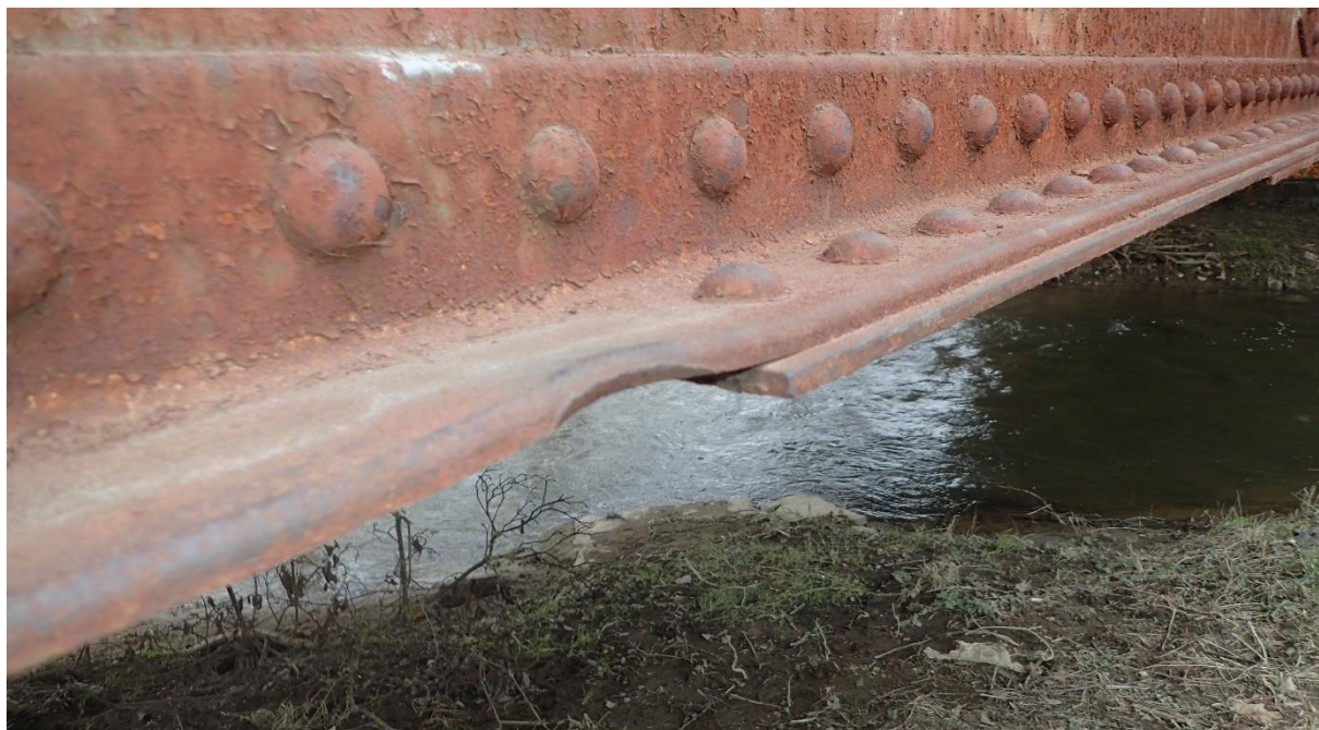
Obr. 21: Deformace spodní pásnice
