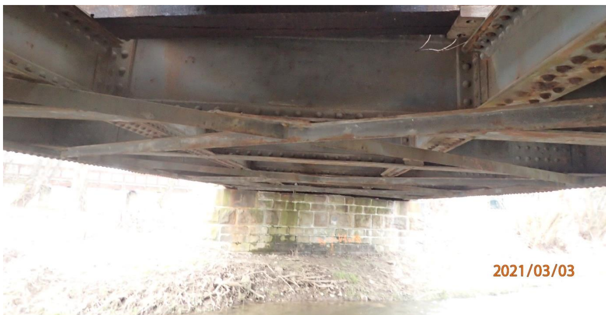
Obr. 19: Poškození PKO a koroze ztužení
