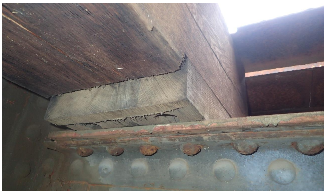
Obr. 43: Uložení mostnic ve spádu přes klíny na podélníky
