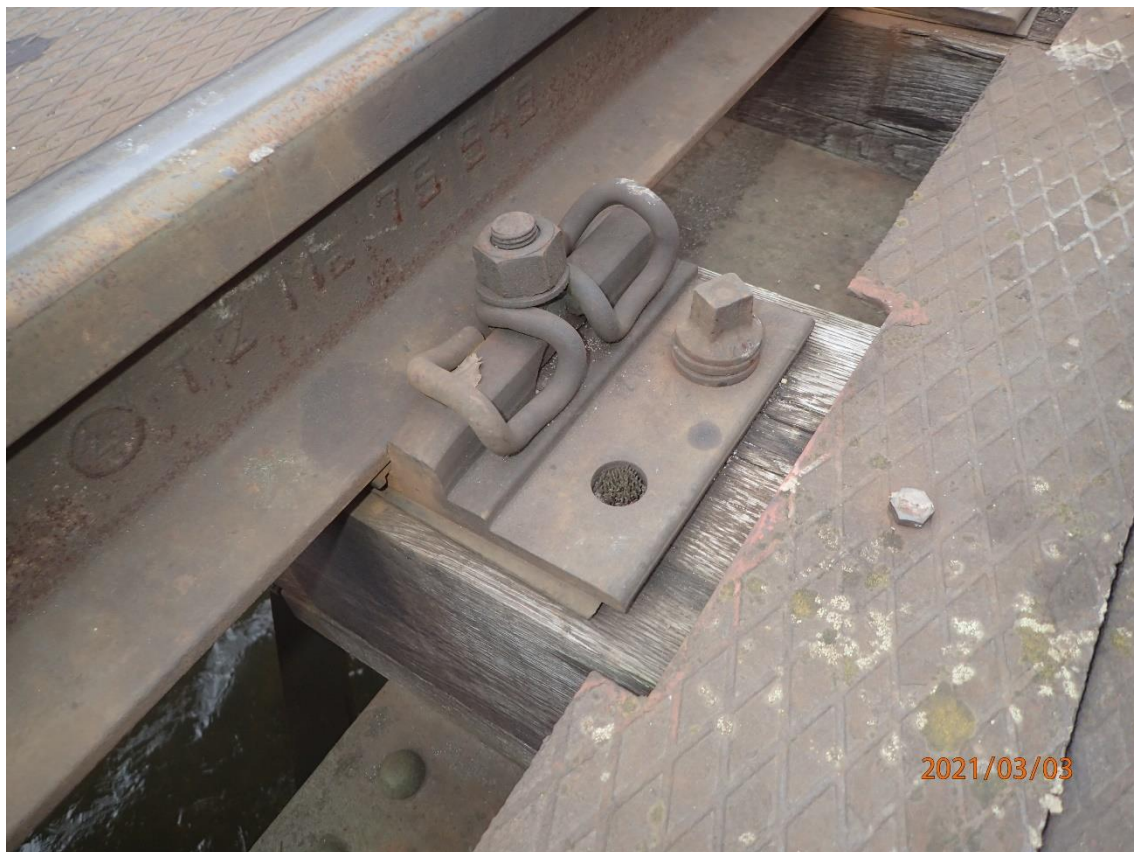
Obr. 40: Chybějící vrtule u podkladnice
