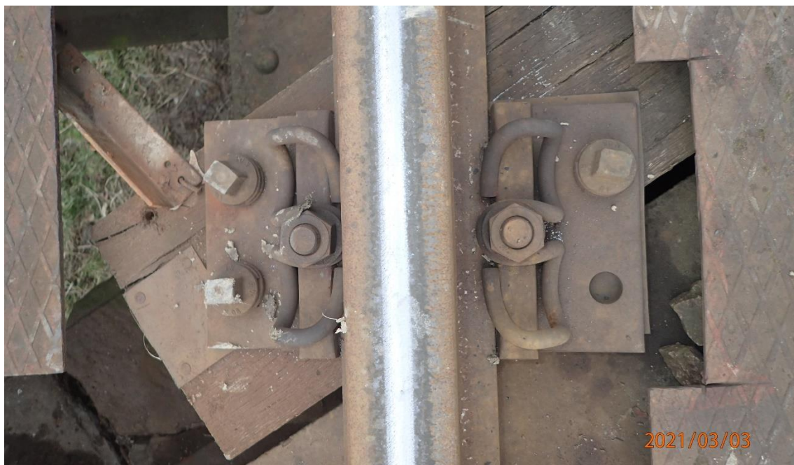
Obr. 41: Nevhodně uložené podkladnice
