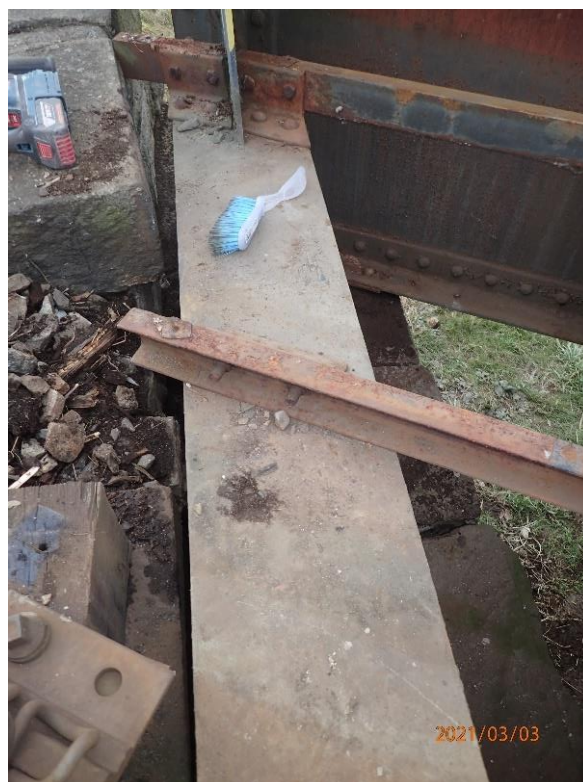
Obr. 26: Demontáž chodníkových plechů a očištění OP1
