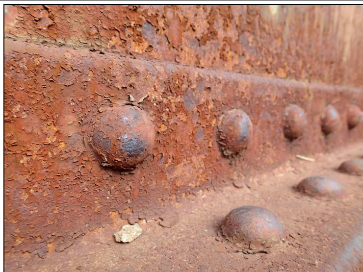
Foto č. 2 – konstrukce K 01 – sešlý nátěr na NK
