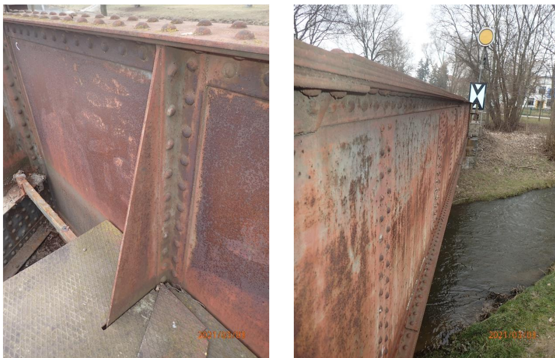
Obr. 13: Poškozená vrstva PKO a koroze – hlavní nosník pravý
