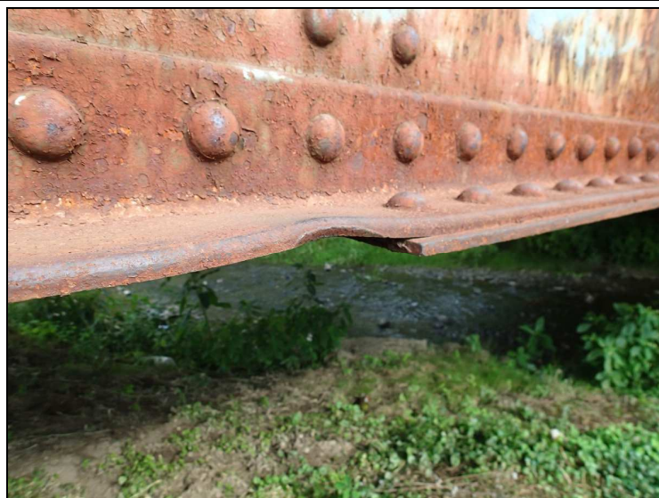
Foto č. 1 – konstrukce K 01 – deformace dolního krčního úhelníku na hlavním nosníku vpravo
