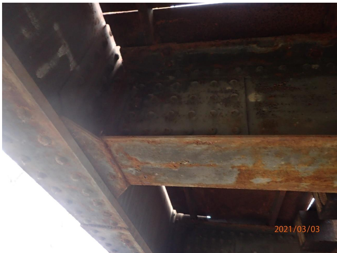
Obr. 18: Poškození PKO a koroze spodní pásnice příčnicku, graffiti
