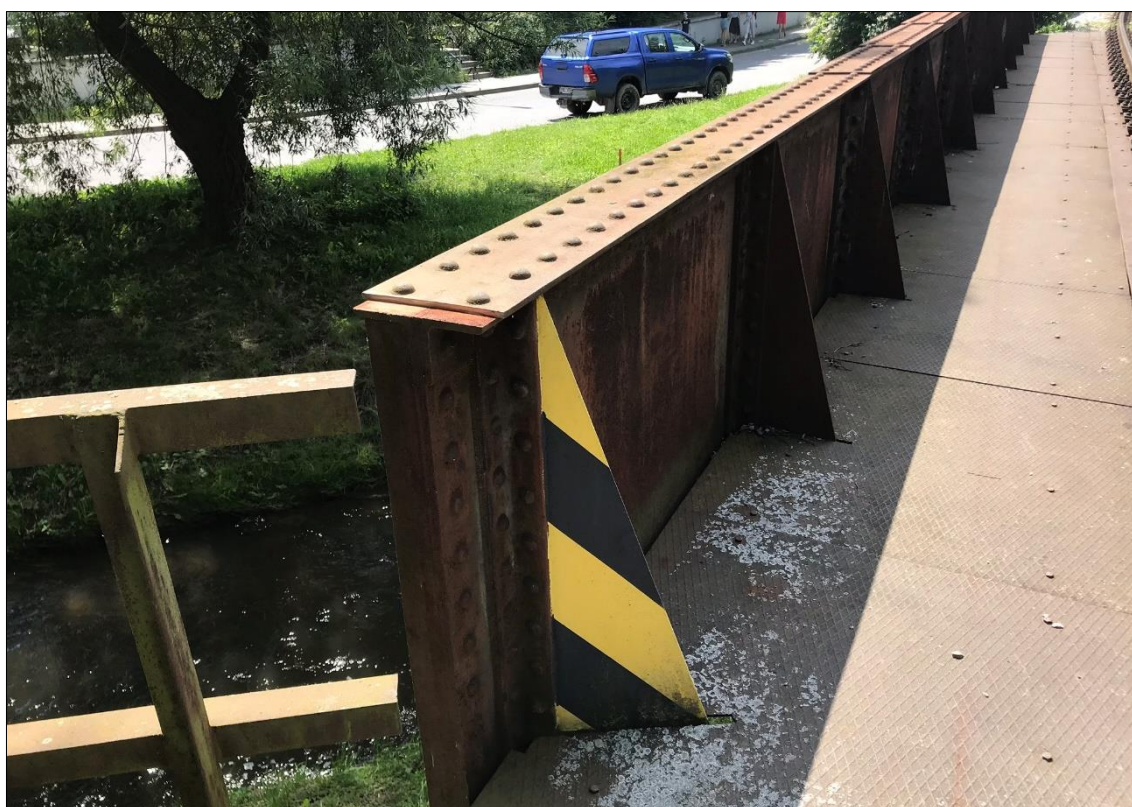
Obr. 2 Pohled na mostní konstrukci. Vzorek 2-3 – horní plát horní pásnice
