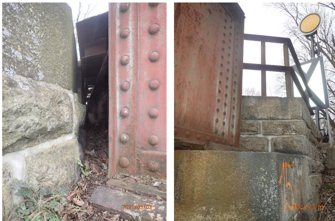
Obr. 35: Tangenciální ložiska u OP2 – původní stav
