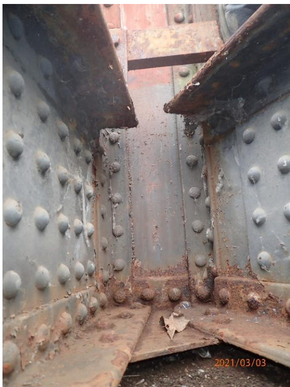
Obr. 26: Demontáž chodníkových plechů a očištění OP1
