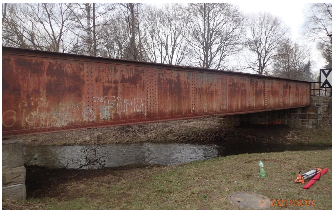
Obr. 16: Koroze a graffiti – hlavní nosník
