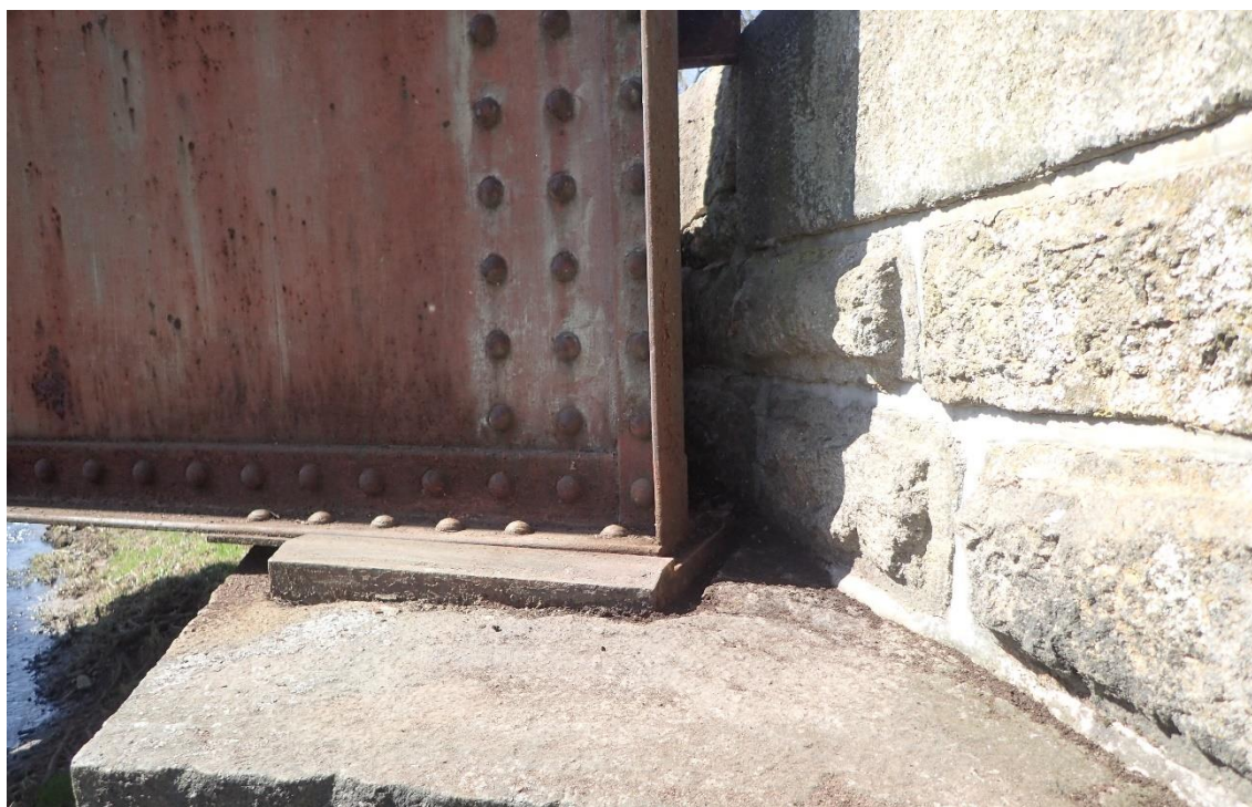
Obr. 38: Tangenciální ložiska a opěra OP2 – po očištění
