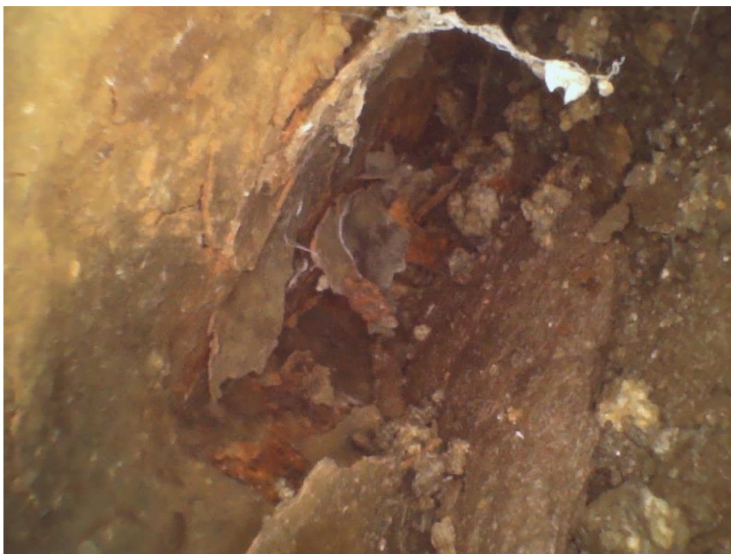
Obr. 32: Poškození vrchní vrstvy PKO koncového příčnicku OP1 (endoskopie)
