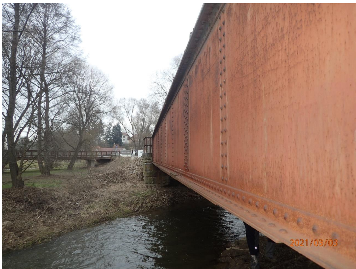
Obr. 15: Poškozená vrstva PKO a koroze – levý nosník
