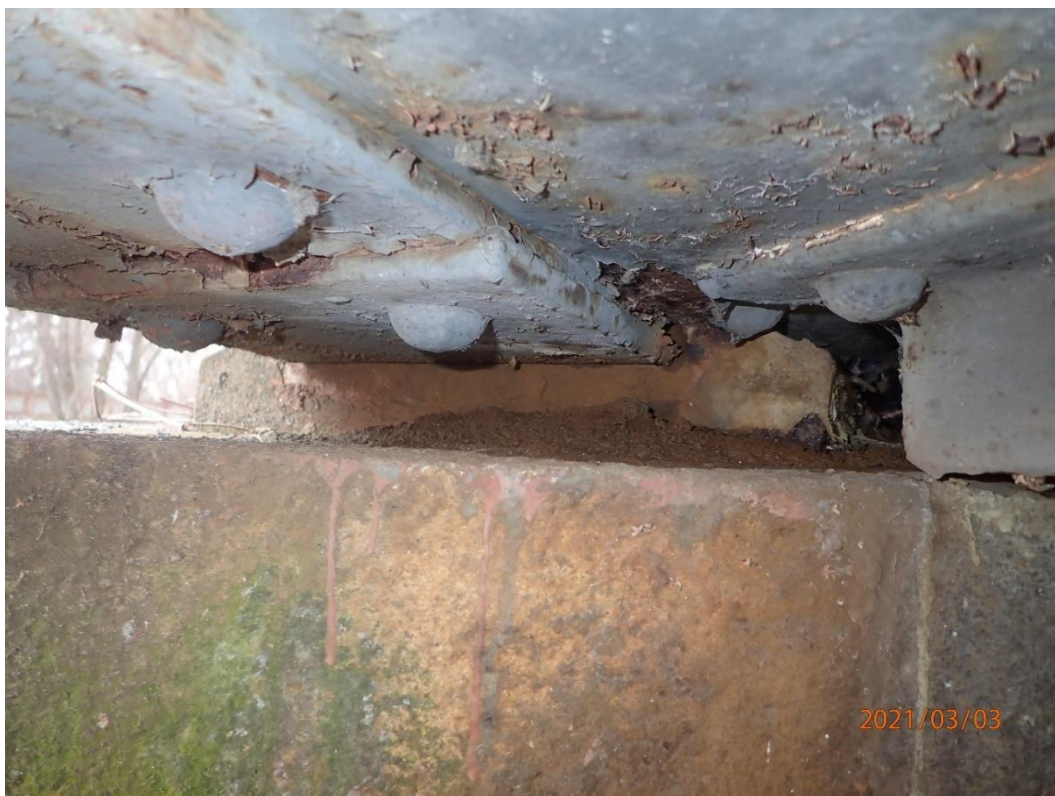
Obr. 24: Poškození a odlupování vrstev PKO v koncové oblasti
