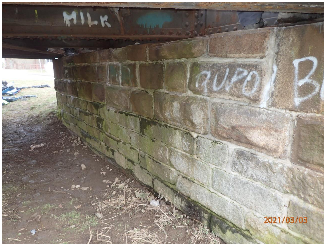
Obr. 45: Pohled na opěru OPI – graffiti, lokální průsak vody a vlhkost
