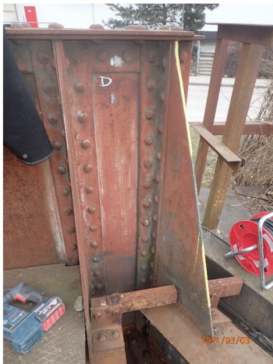
Obr. 14: Poškozená vrstva PKO a koroze – horní pásnice a koncová výztuha
