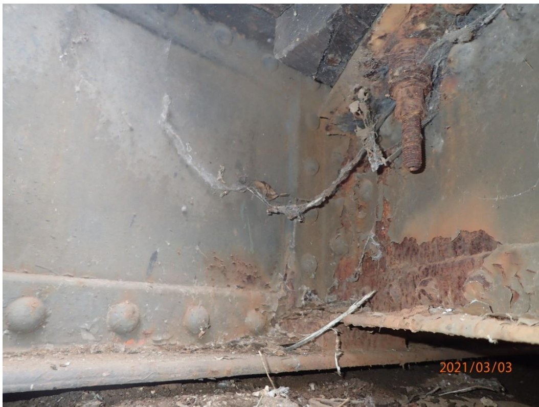
Obr. 25: Koncová oblast OP1 před očištěním
