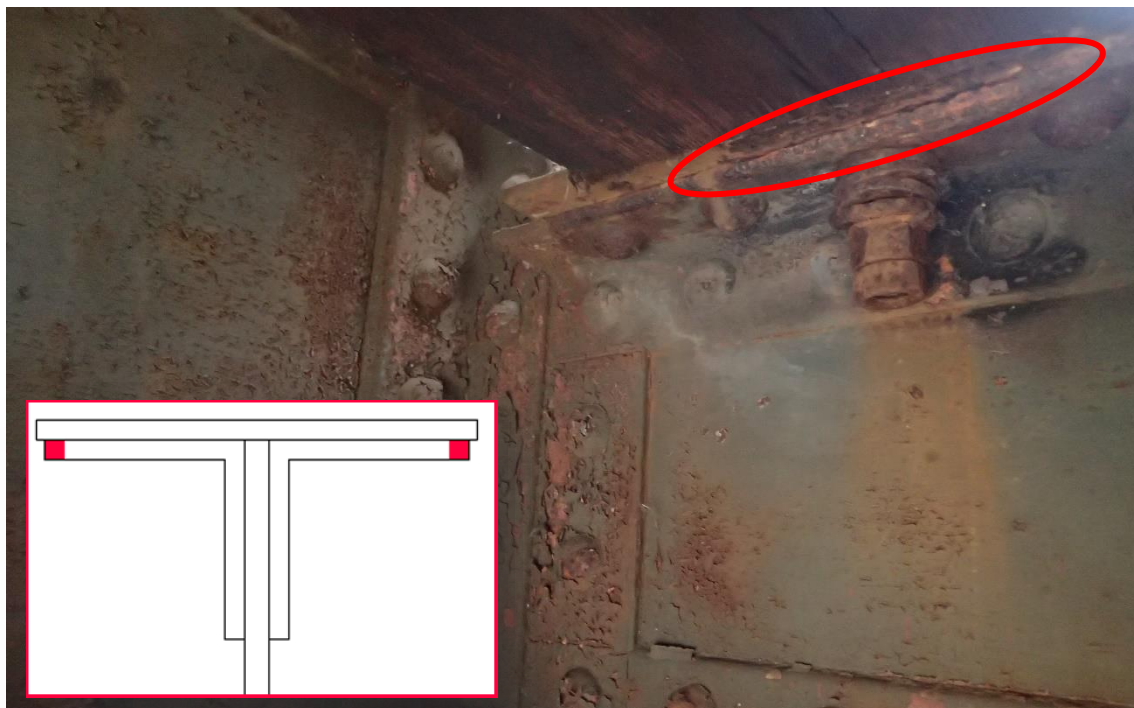
Obr. 33: Štěrbinová koroze podélníků pod mostnicemi
