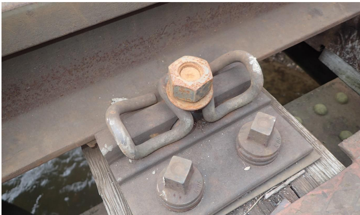
Obr. 42: Lokální koroze matice podkladnice
